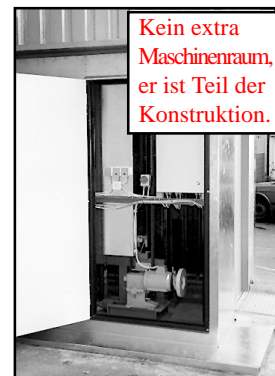
Außen angehängter Aufzug
