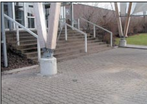
Gefährliche Treppenanlagen ohne Kontrast-Markierungen, mit Kantenbrüchen etc.. Ausladung der Stütze im Bild links kann innerhalb von 30 cm Höhe vom Boden nicht mit einem Taststock erfasst werden und ist deshalb gefährlich für blinde Menschen.
