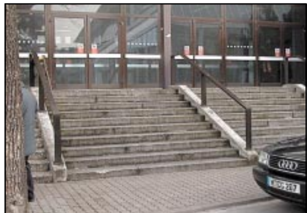
Gefährliche Treppenanlagen ohne Kontrast-Markierungen, mit Kantenbrüchen etc.. Ausladung der Stütze im Bild links kann innerhalb von 30 cm Höhe vom Boden nicht mit einem Taststock erfasst werden und ist deshalb gefährlich für blinde Menschen.
